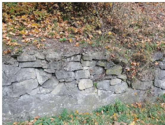
Fot. 9. Uszkodzenia muru oporowego
