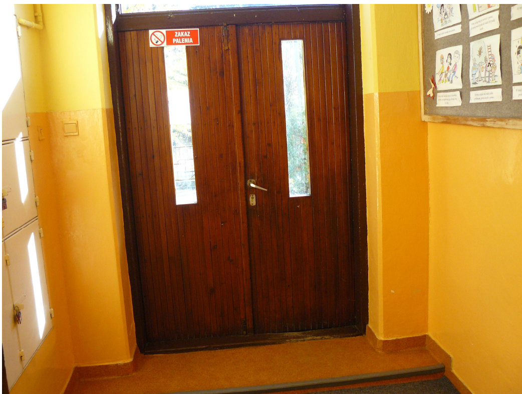
Fot.6 Wejście główne od frontu do części A widok na drzwi wejściowe, ślady mocnego wyeksploatowania stolarki, Szkoła Podstawowa w Glince
