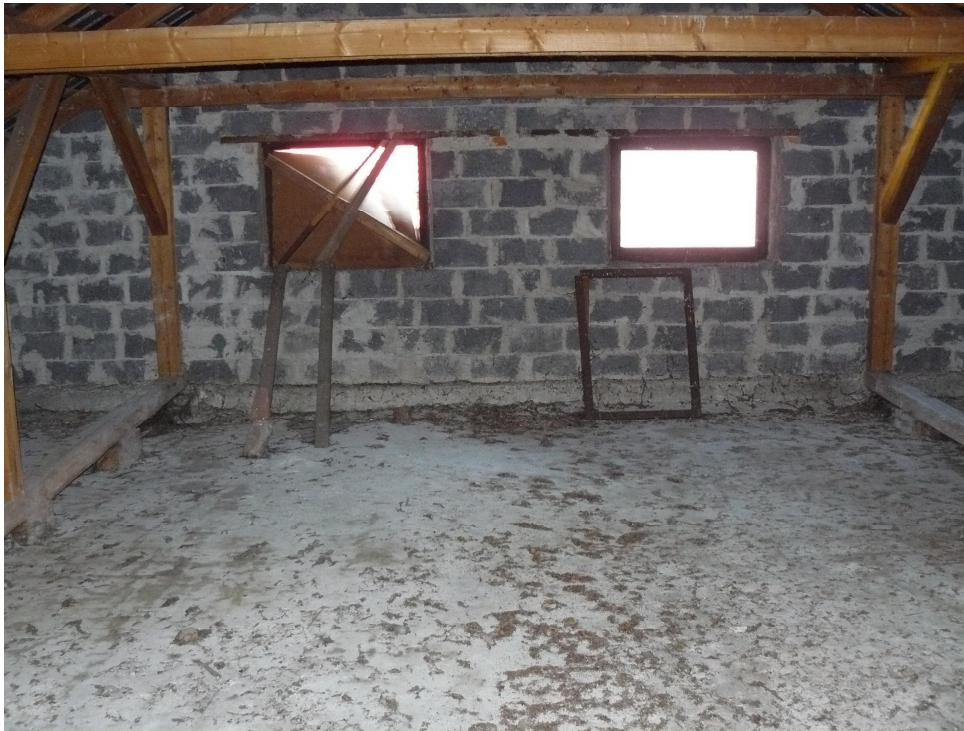
Fot.5 Poddasze części A widok na strop oraz ścianę szczytową–brak docieplenia oraz szklenia w stolarcie okiennej ściany szczytowej, Szkoła Podstawowa w Glince
